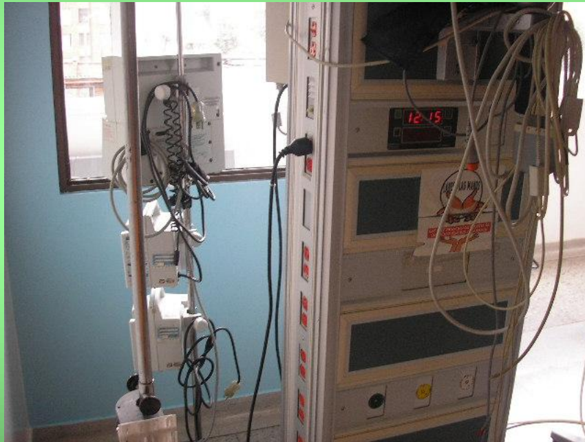
COLUMNAS DE SERVICIO
